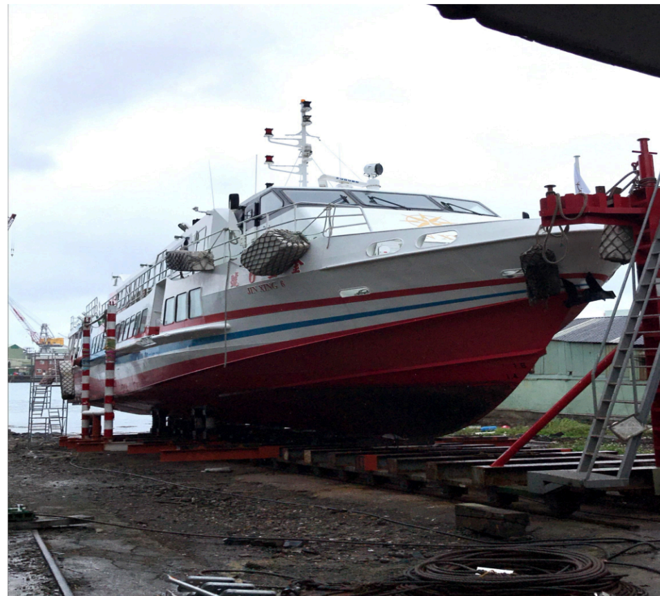
金星 6 號 | 2020 上架施工期間 ( 基隆 )
